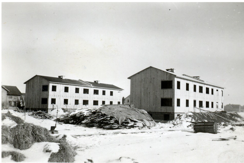
Hyreshusen längs Industrivägen under byggnad.
